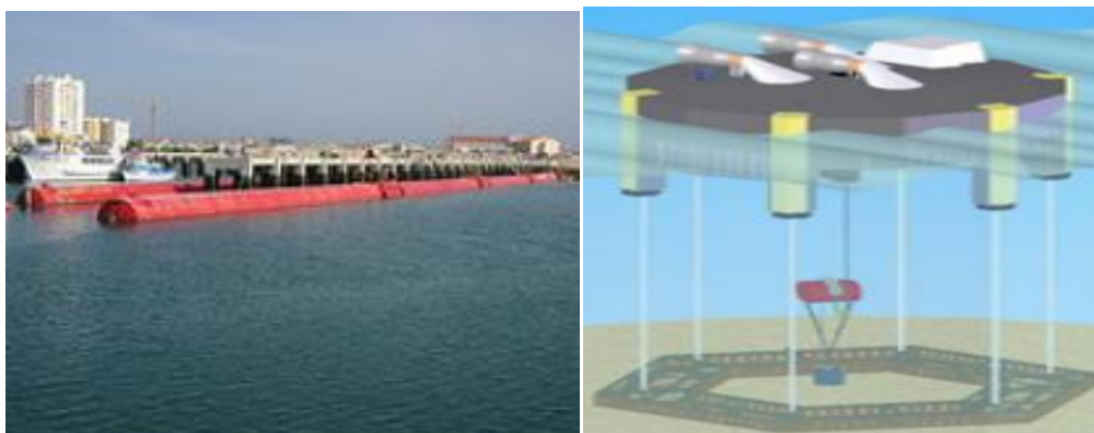
Figura 1.15 - Instalații tip Pelamis care recuperează energia valurilor (stânga), platforma maritimă a firmei Orecon (dreapta)
